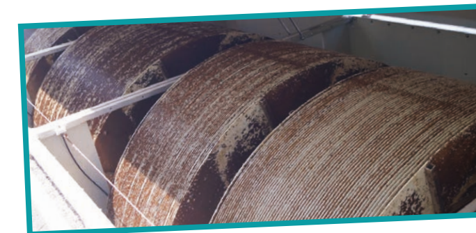
Rotierende Scheibentauchkörper mit biologischem Rasen
