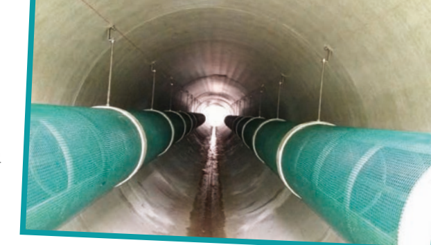
Stauraumkanal mit Grobstofffiltern
