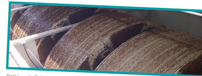
Rotierende Scheibentauchkörper mit biologischem Rasen
