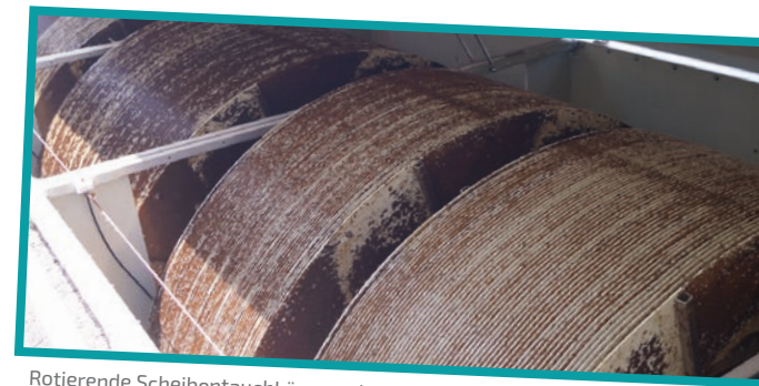
Rotierende Scheibentauchkörper mit biologischem Rasen
